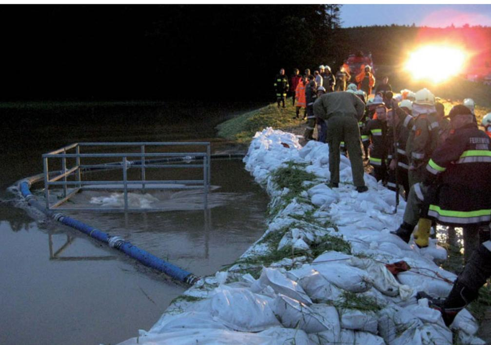
Damm mit Sandsäcken erhöht und Schutzwall aus Saugschläuchen gegen mitgeschwemmtes Holz
