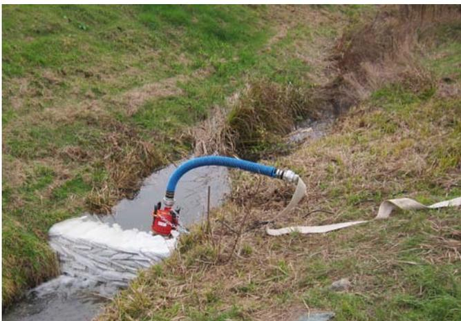
Aufstauen des Baches und Ansaugen mit Tauchpumpe
